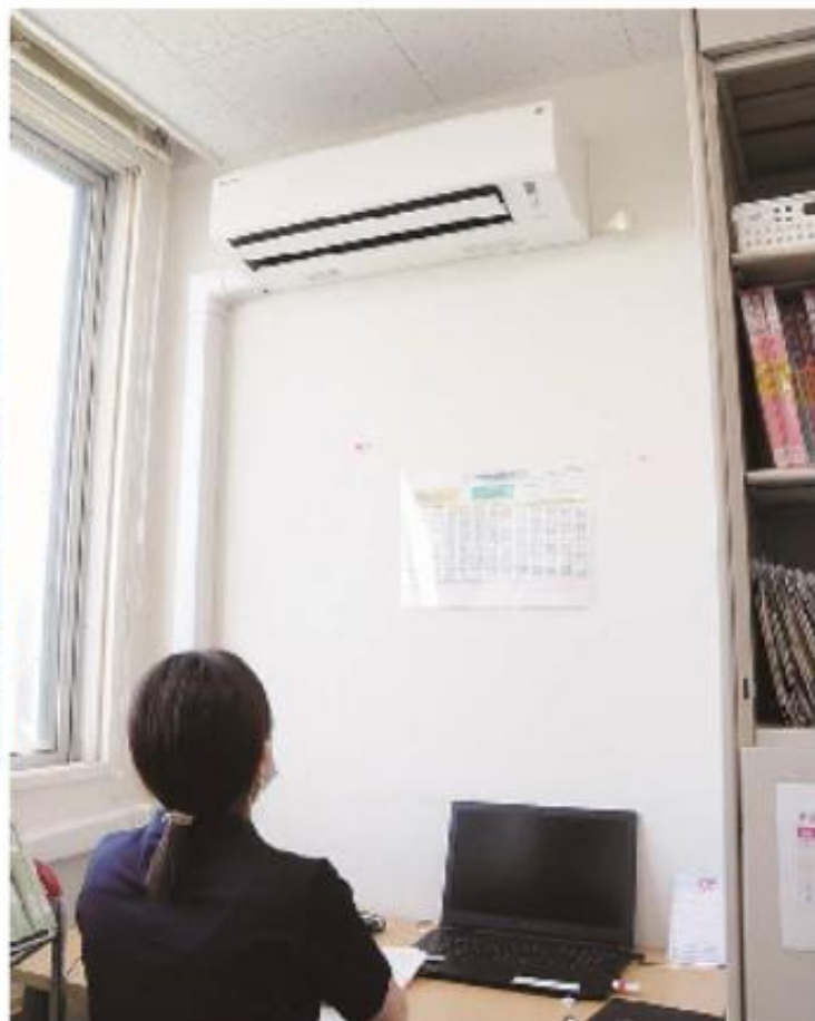
エアコンの設置を進める室蘭太平洋病院
